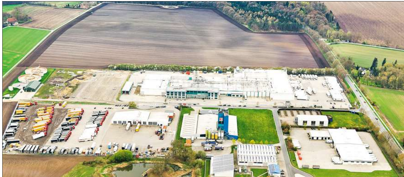
Das Gewerbe- und Industriegebiet Lether Gewerbestraße: Auf einem westlich an Heidemark angrenzenden Ackerstreifen will Kreienkamp bauen. Zugleich soll eine Erweiterungsfläche für Heidemark ausgewiesen werden. BILD: JOCHEN KLEIN/OL-LUFTBILDER.DE
